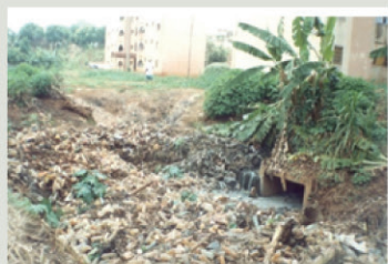
Absence de systèmes d'assainissement des eaux
